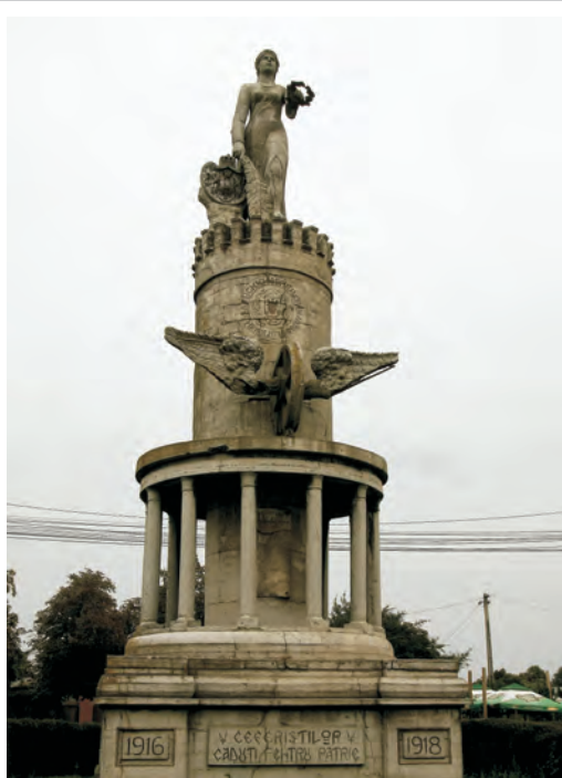
Monumentul Eroilor Ceferiști din Tecuci/ Monument of the Railway Men Heroes of Tecuci
